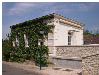
Cantine scolaire en rez-de-chaussée
