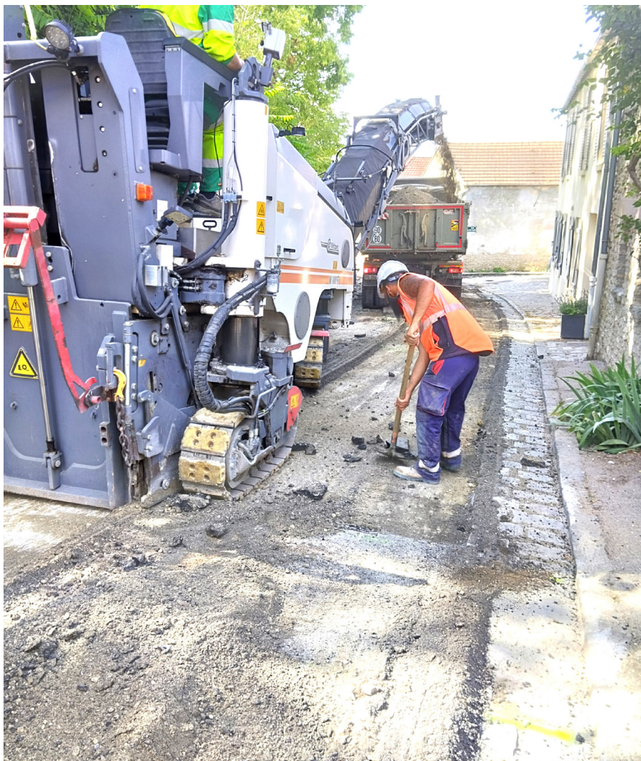
Juillet 2023. Rénovation de la Grande Rue.
